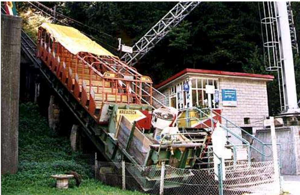
Die Kreuzeck-Höhenbahn - ein Schrägaufzug
